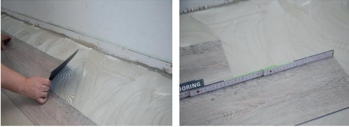
Anschließend werden die Elemente vollflächig mit einem geeigneten Anreibgerät angedrückt. Hierzu empfiehlt sich eine Handandrückrolle oder ein Anreibbrett. Um ein ideales Verlege- und Nutzungsergebnis zu erzielen, ist auf eine gute Klebstoffbenetzung des Belagrückens zu achten.
