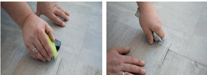
Im Anschluss nach dem manuellen Anreiben und Zuschneiden der Elemente erfolgt zeitnah das gleichmäßige und langsame Anwalzen des Belages mittels einer Gliederwalze (Gewicht mind. 50kg). Für den unzugänglichen Bereich der Gliederwalze vor allem im Randbereich wird eine Handandrückrolle empfohlen.
